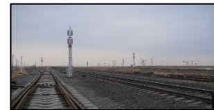
Access railway, «Karabatan» st. extension Length – 15,4 km.
